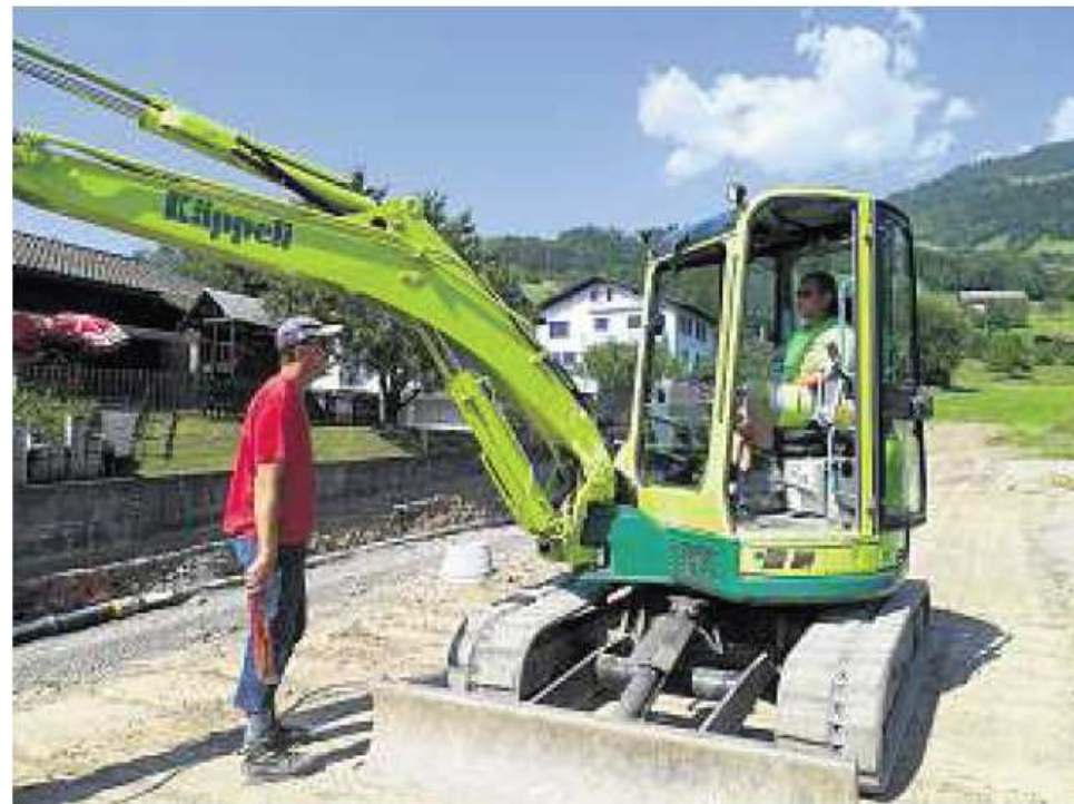
Projekt kommt voran: Carl-Heinz Schottroff (links) hat die Wasserleitung bereits angeschlossen. Bild Urs Affolter
